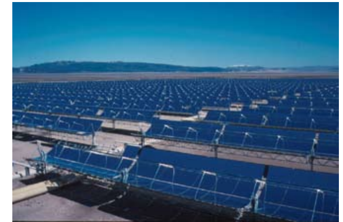
In Solarkraftwerken treibt eine bis auf 500° C erhitzte Flüssigkeit Turbinen an – auch wenn keine Sonne scheint.
